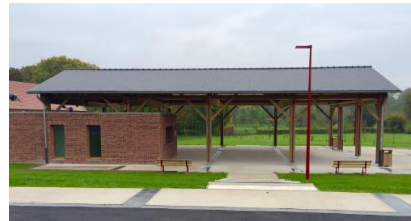
Exemple : la halle de Wavrechain sous Faulx
