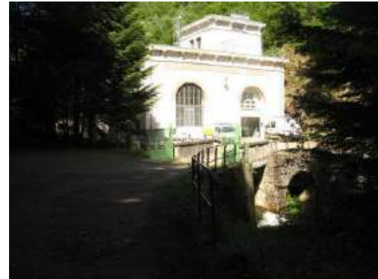
Centrale hydroélectrique de la Canche à Roussillon-en-Morvan
