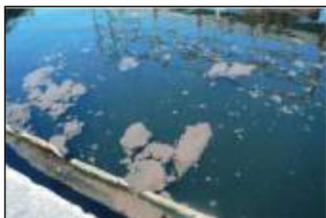
Départ de boues dans un décanteur suite à un à-coup hydraulique – CD71 ©.
