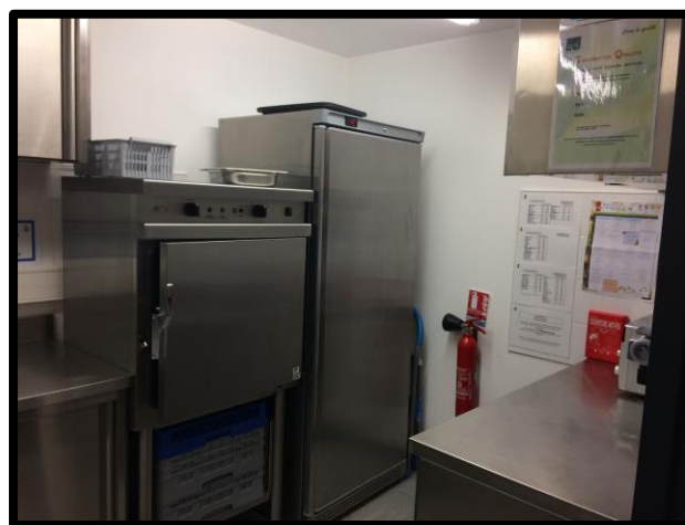
Figures 17, 18, et 19 : Cuisine de l'école de Viel Saint Rémy 23.06.2021 (photos réalisées par Juliette GAUDRON)
