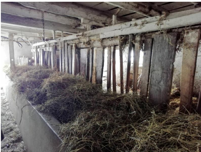
Figure 25 : Râteliers d'époque (Source : Auteur)
