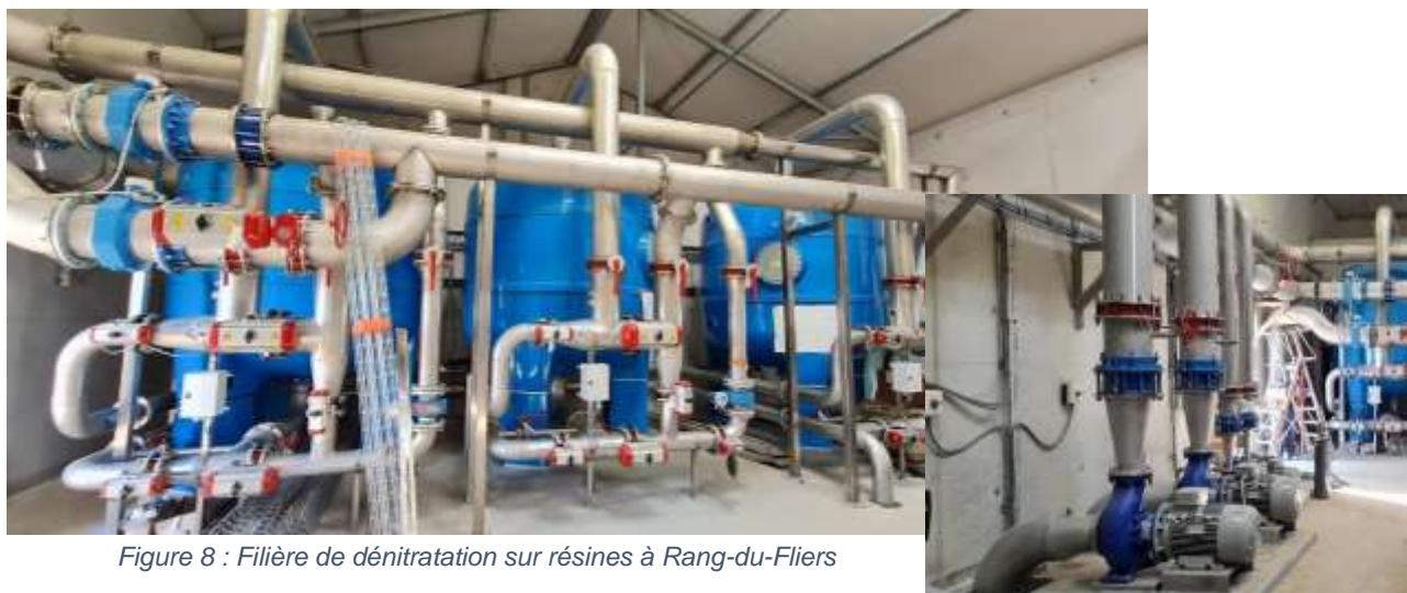
Figure 8 : Filière de dénitrification sur résines à Rang-du-Fliers
